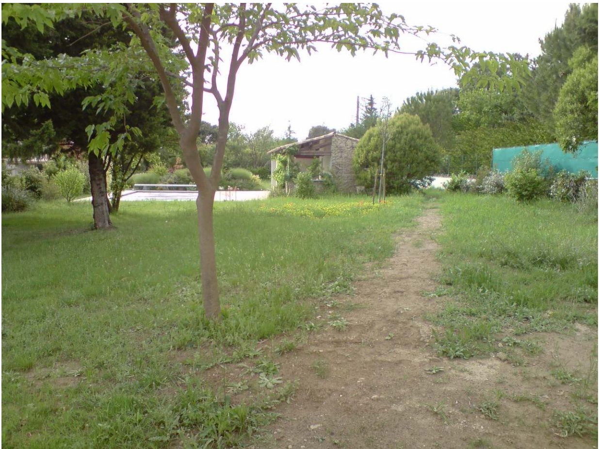
La tranchée de liaison vers la piscine
