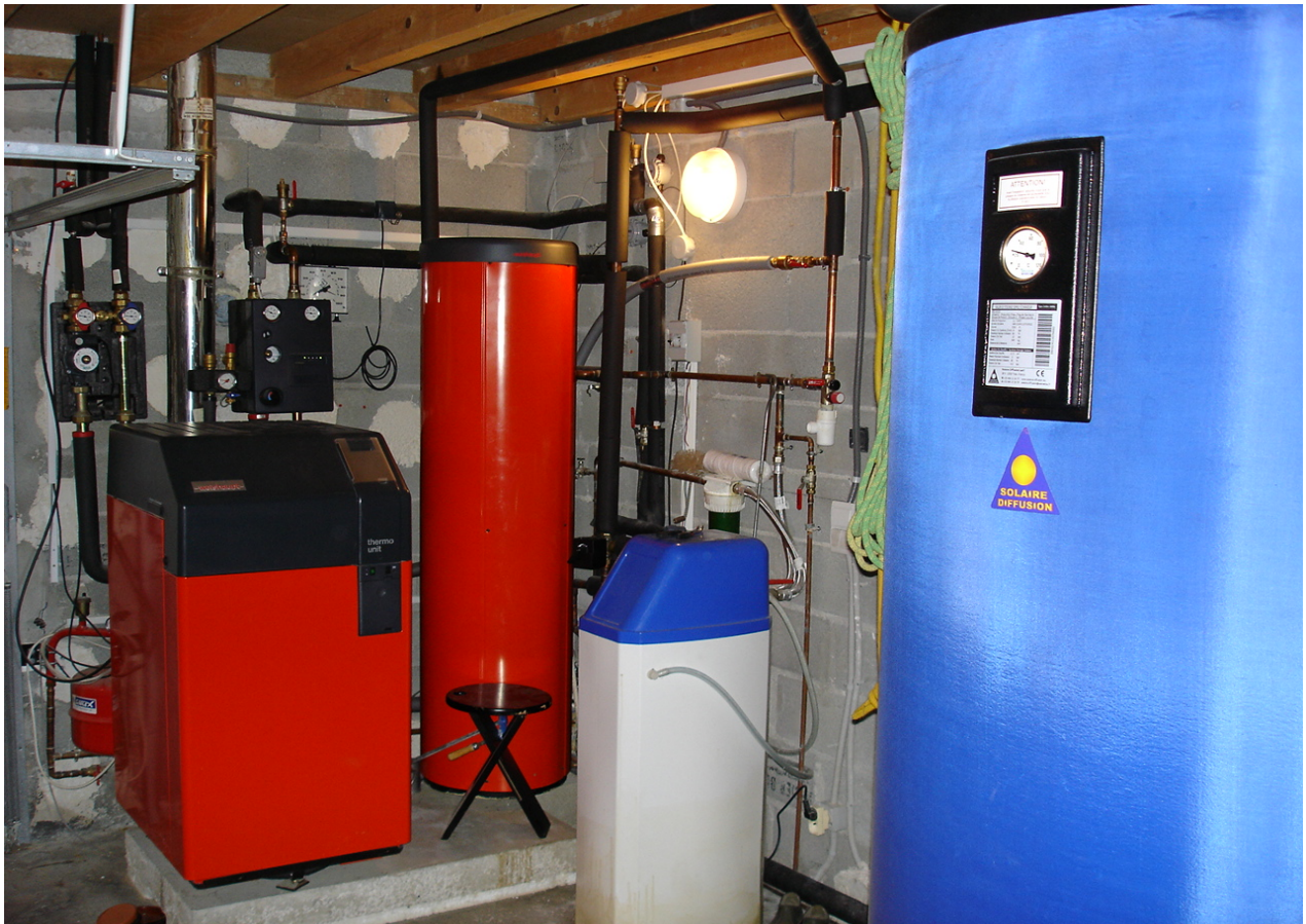
L'installation coté chaudière
