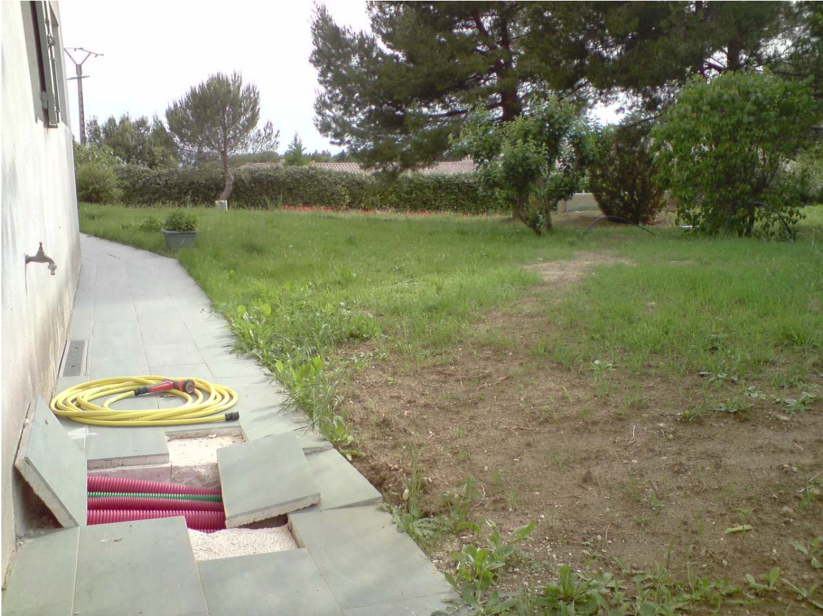
Le passage des canalisations dans le mur et au fond sous les arbres, l'arrière du mur des capteurs
