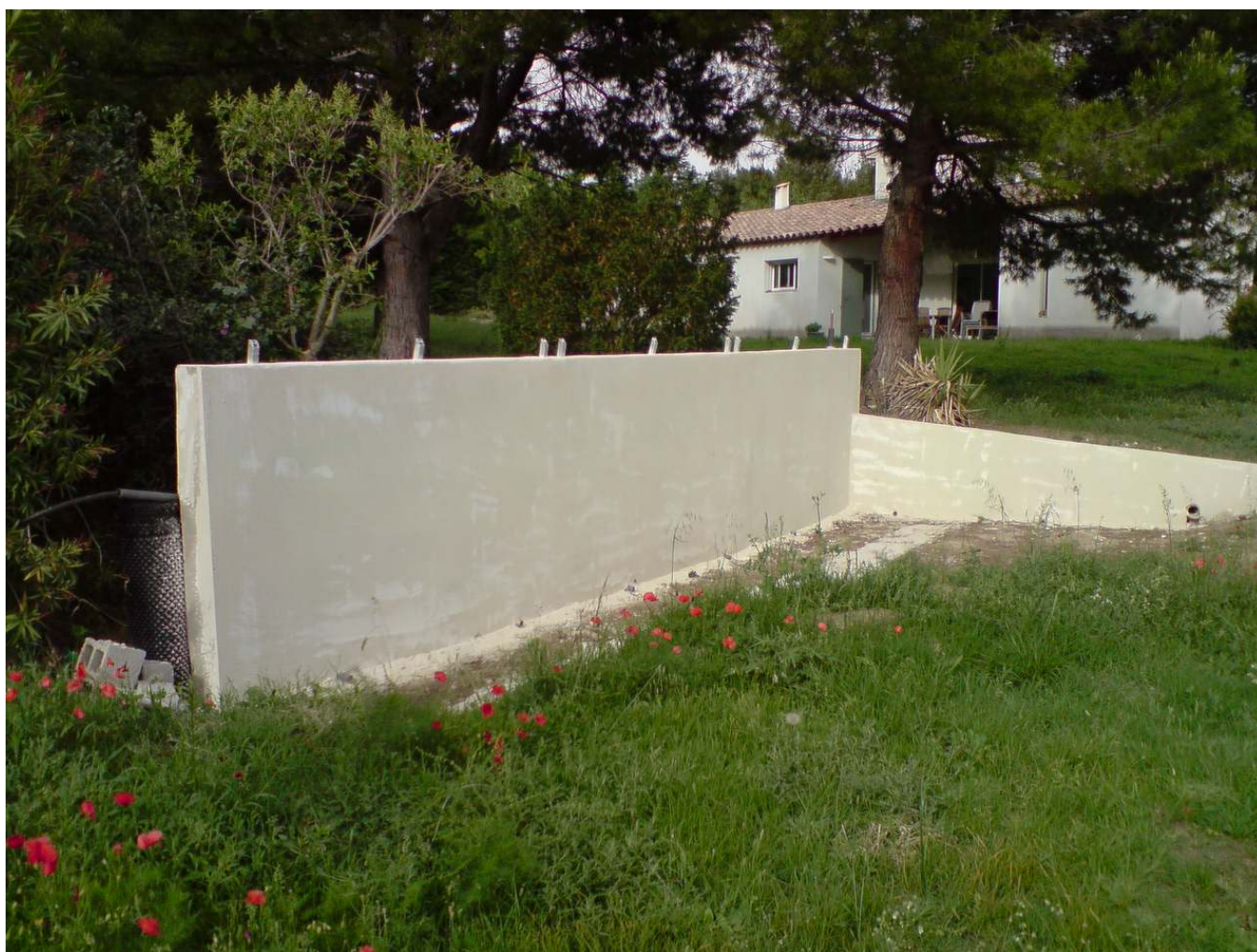
Mur pour la pose des capteurs
