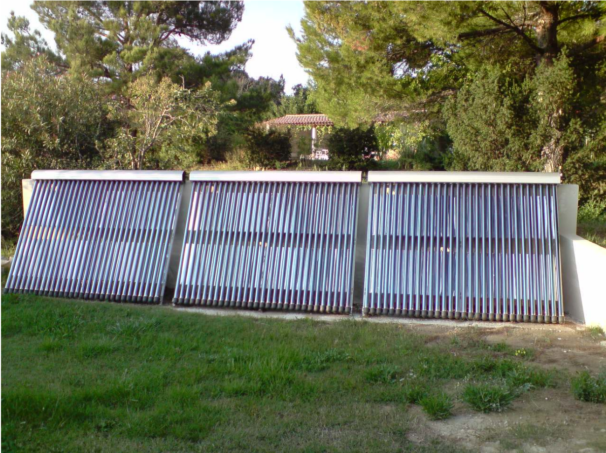
Les 90 tubes posés
