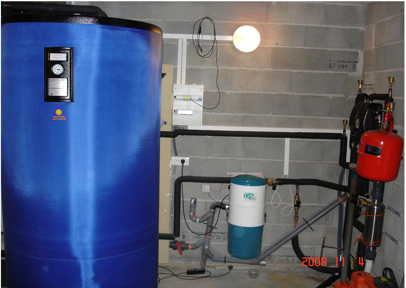
Le ballon installé avec le M3 et la station solaire
